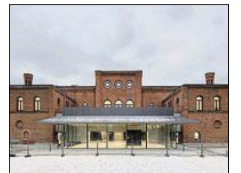
Das Treppenhaus und der verglaste Pavillon im Ehrenhof.
