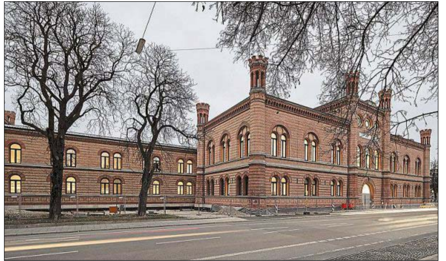
Ende 2018 zog die Fakultät für Design in das vom Büro Staab Architekten renovierte Zeughaus an der Lothstraße.
