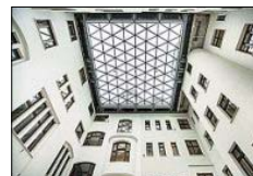
Das neu überdachte Atrium.
