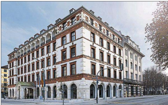
Das generalsanierte Stammhaus der IHK für München und Oberbayern.
